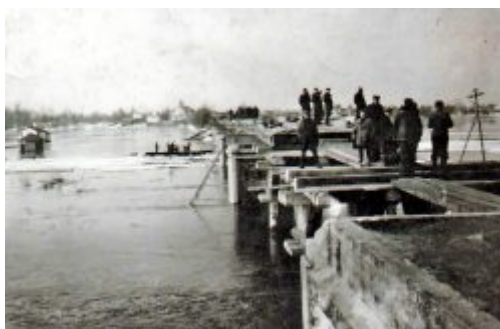
Budowa mostu na Tyśmienicy
