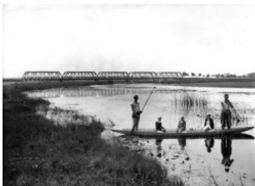
Most na Tyśmienicy w Kocku fot. Majewski
