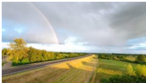
Widok z wiaduktu nad trasą S-19 - Fot. Jurek Wawerek
