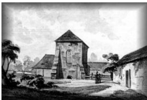
Dawny budynek zakrystii
