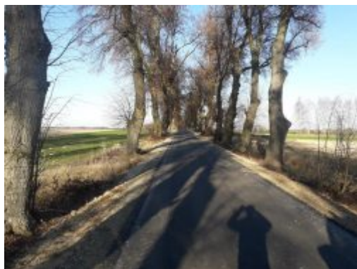
Przebudowana droga gminna w Wygnance
