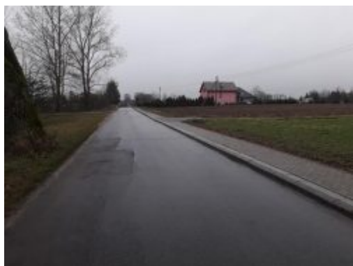
Budowa chodników przy drogach gminnych w Talczyne
