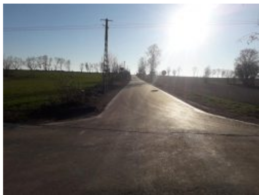
Przebudowana droga gminna w Białobrzegach
