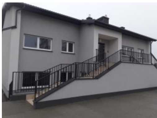
Przebudowany na 8 mieszkań socjalnych budynek starej szkoły w Annopolu
