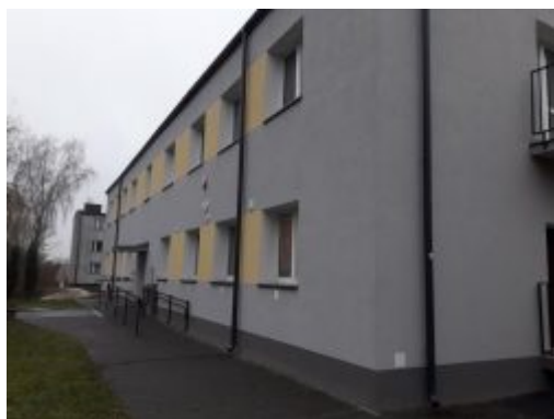
Termomodernizacja budynku Warsztatu Terapii Zajęciowej w Kocku
