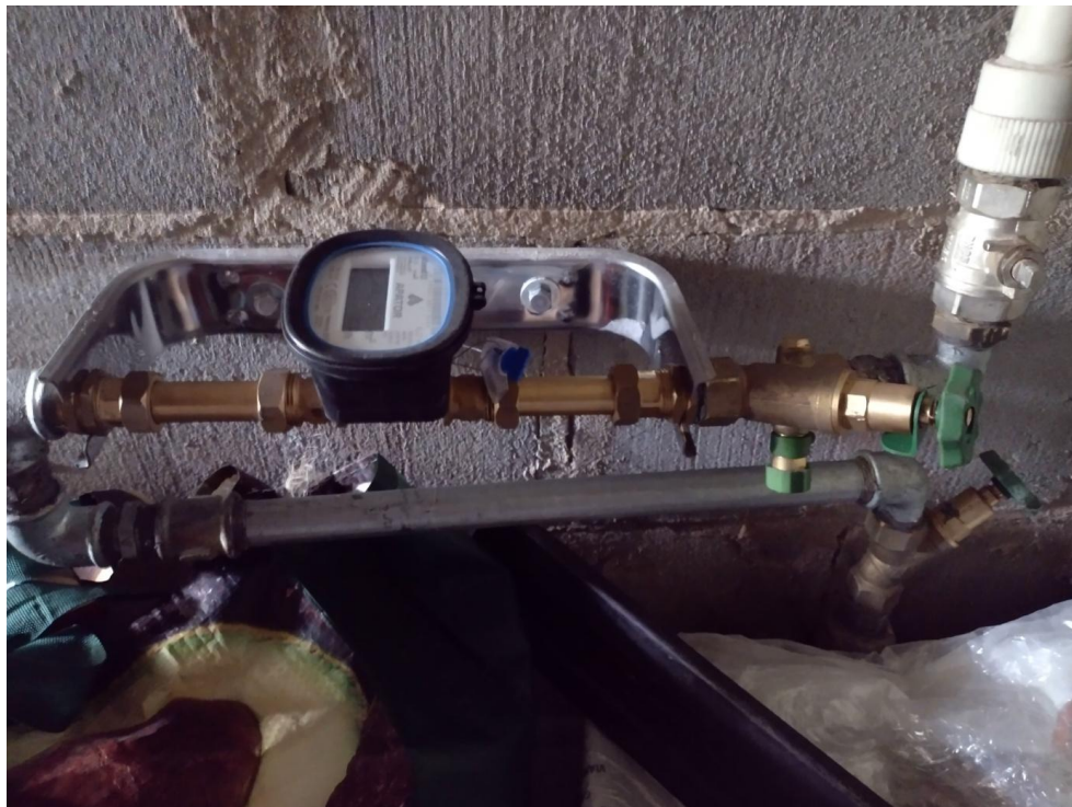
Zestaw wodomierza ultradźwiękowego.
